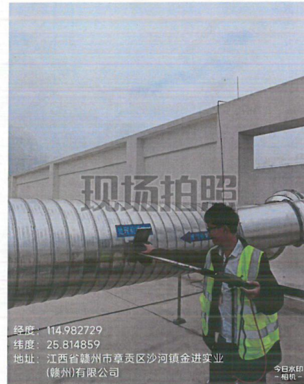
焊锡废气 1 (进口)
